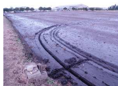
図2：代かき後の排水溝の設置
